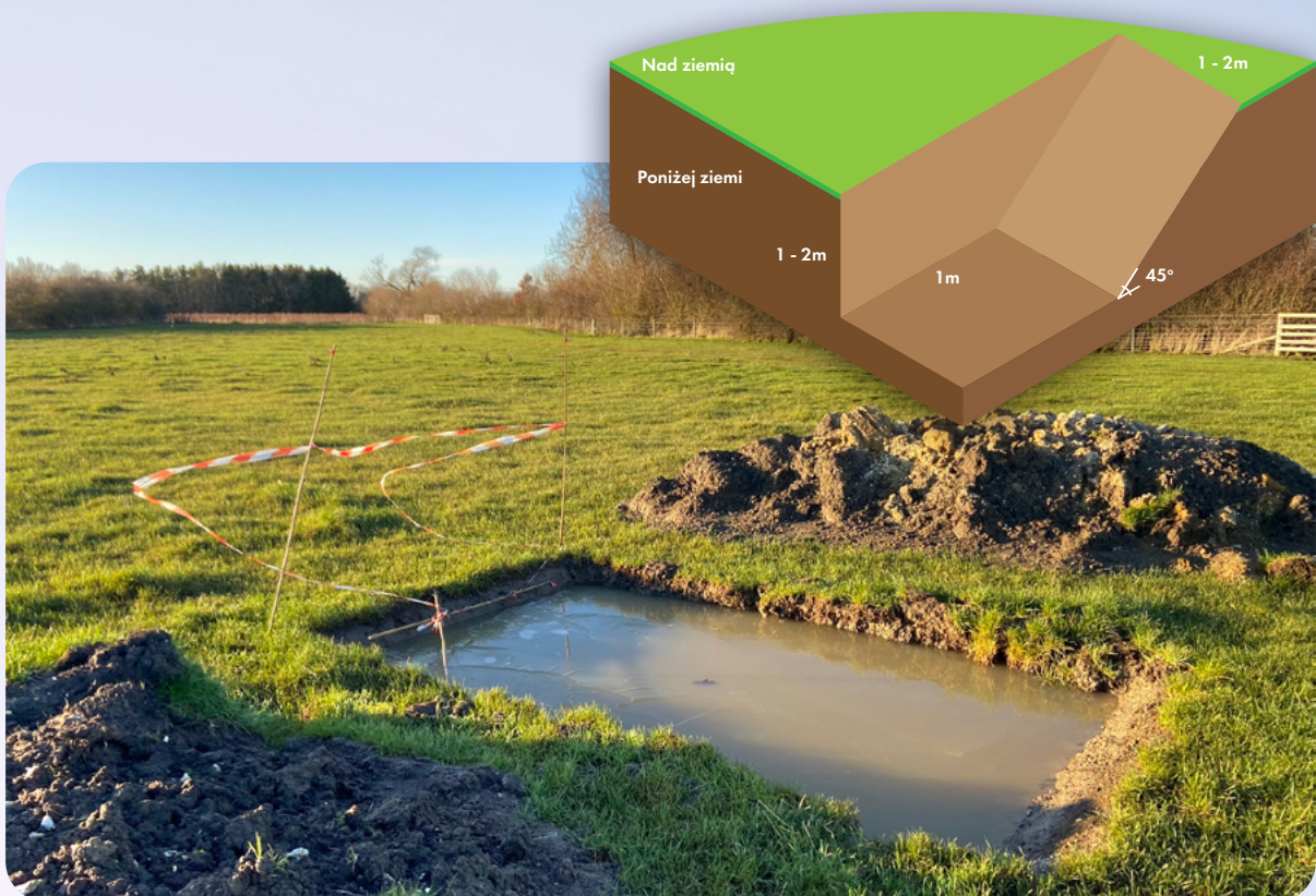
Otwory próbne służą do oceny podłoża i hydrologii nowego stawu przed rozpoczęciem budowy. © Freshwater Habitats Trust
