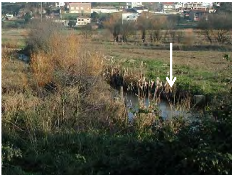
Fotografia do local de instalação de descarregador no Rio Jardim. É visível a estrutura de apoio (assinalado com setas), já existente, dum adufa de controlo.
