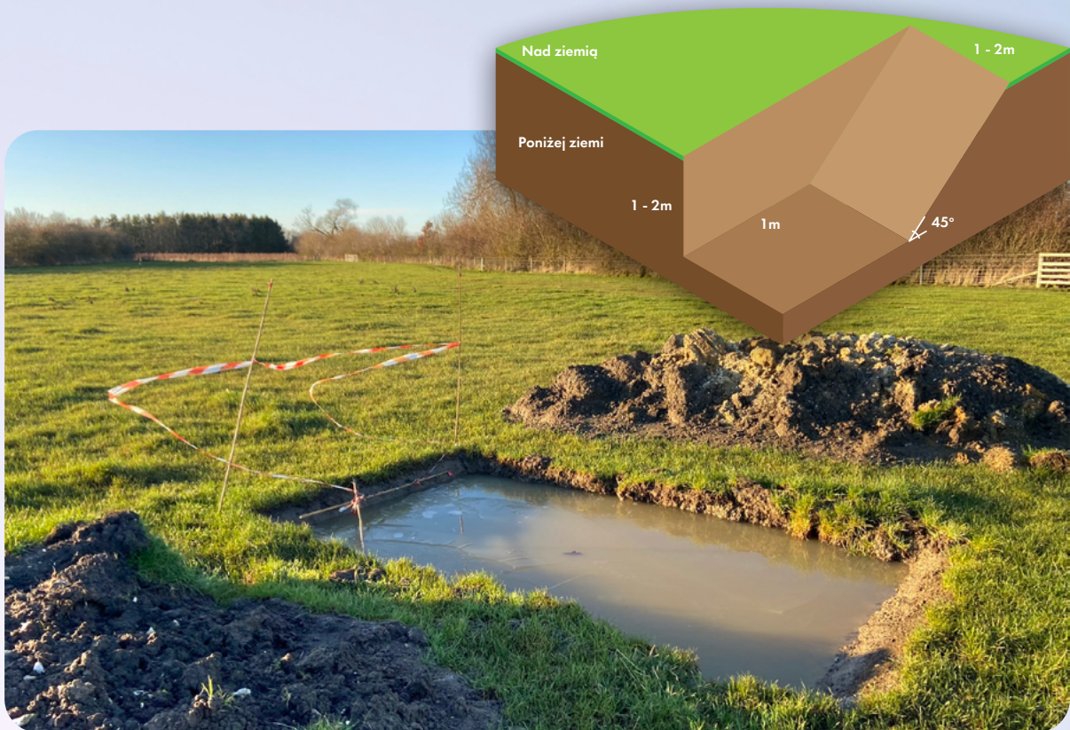
Otwory próbne służą do oceny podłoża i hydrologii nowego stawu przed rozpoczęciem budowy. © Freshwater Habitats Trust
