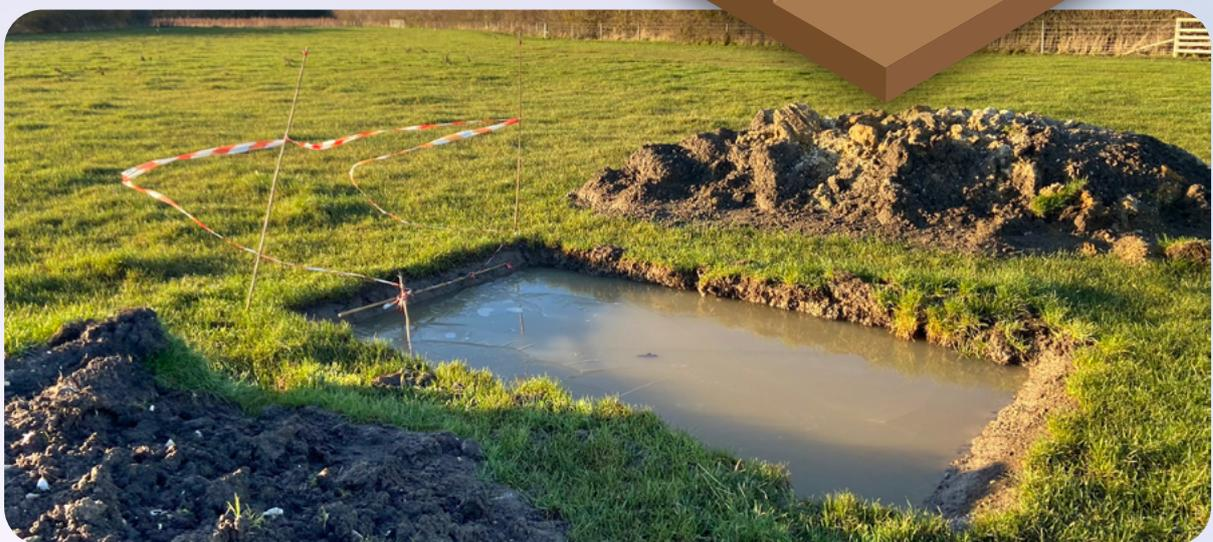
Os buracos de ensaio são usados para avaliar o substrato e a hidrologia de um novo local potencial para a construção de um charco antes de iniciar a construção. © Freshwater Habitats Trust
