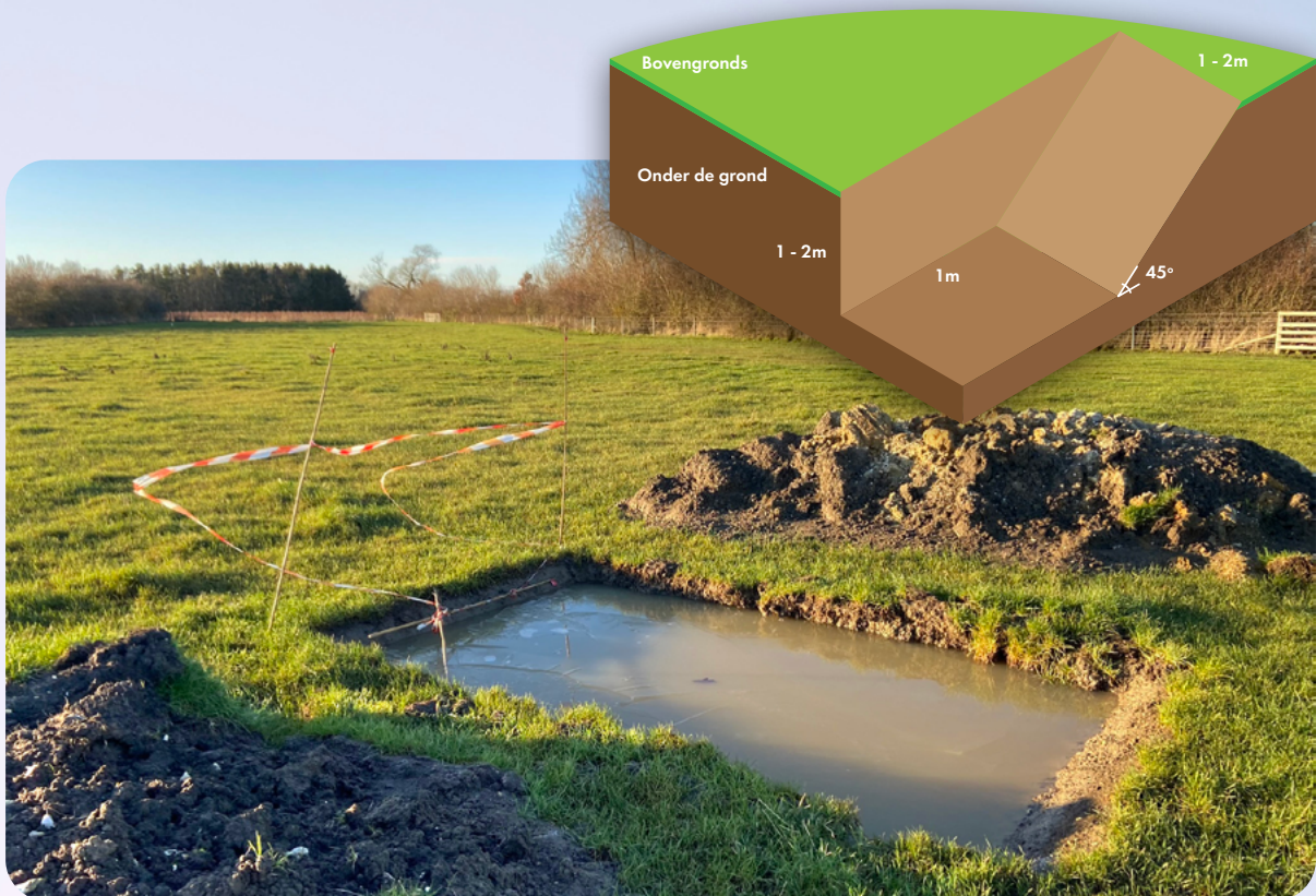
Mithilfe von Probebohrungen werden der Untergrund und die Hydrologie eines neuen Teichs beurteilt, bevor mit dem Bau begonnen wird. © Freshwater Habitats Trust
