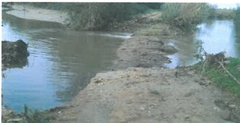
Figura 6- rombo na margem sul do esteiro de Canelas, na cheia de 2015 (in: http://www.terranova.pt/noticia/politica/cira-anuncia-nova-fase-na-reparacao-de-rombos-no-baixo-vouga , consultada em 13-01-2017)
